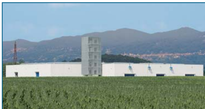
Sede amministrativa, produttiva e logistica - Brebbia (Italy) Administrative, production and logistic site - Brebbia (Italy)
